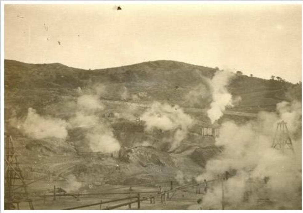
Larderello. Condotture di vapore, perforatrici con argano a mano. 1912
