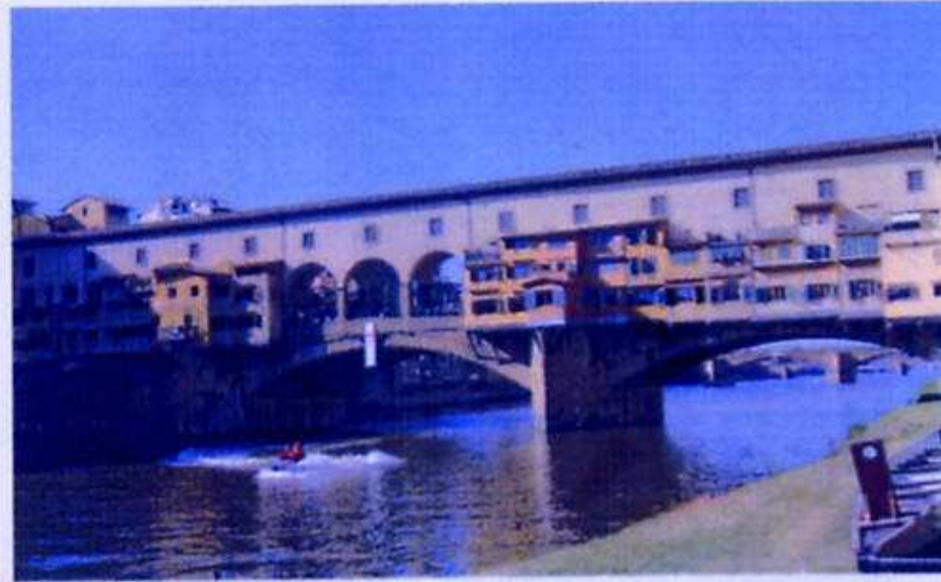
Ponte Vecchio restored
